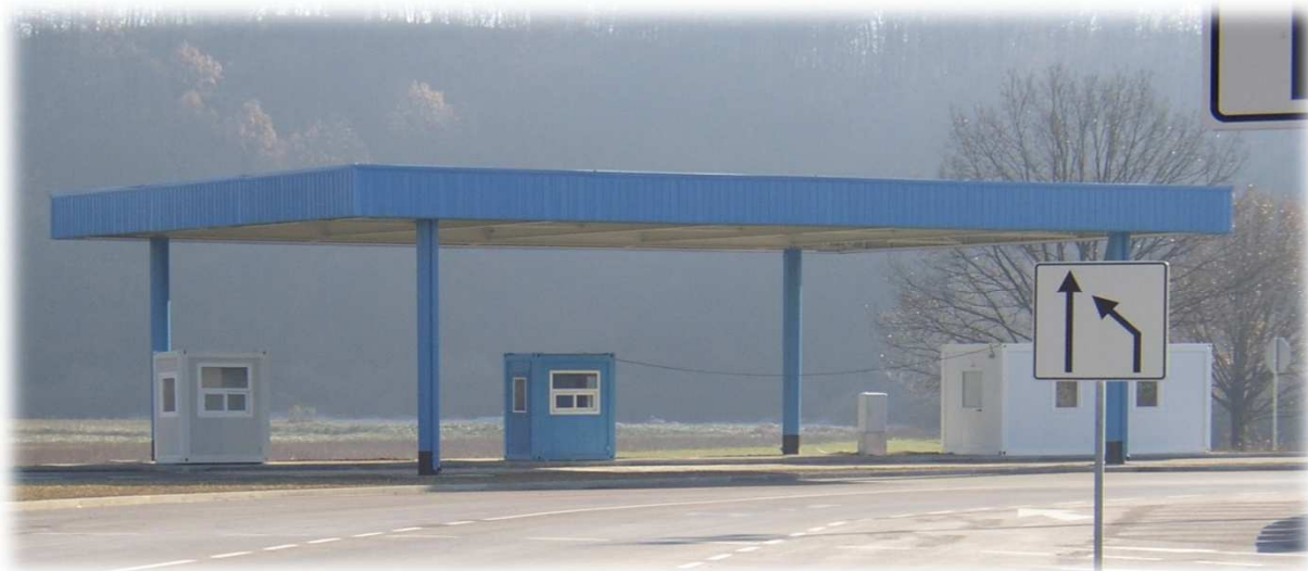
kontrola ulaza teretnog prometa
